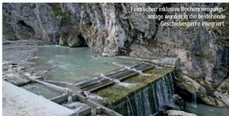
Feinrechen inklusive Rechenreinigungsanlage wurden in die bestehende Geschiebesperre integriert.
